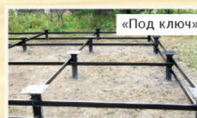
Свайный фундамент от 3 500 рублей
