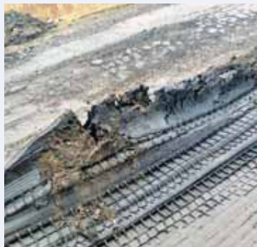
▲ Эту дорогу ремонтировали в прошлом году
