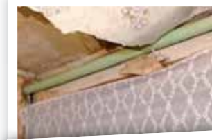
В доме отклеиваются обои
