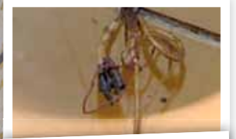
Проводка стала уже непригодной
