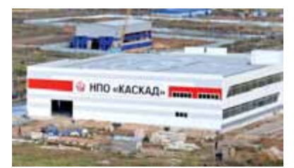
▲ Строящееся административно-производственное здание
