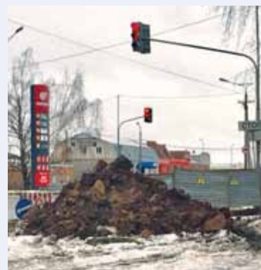
▲ Отопления не было из-за проводимых работ
