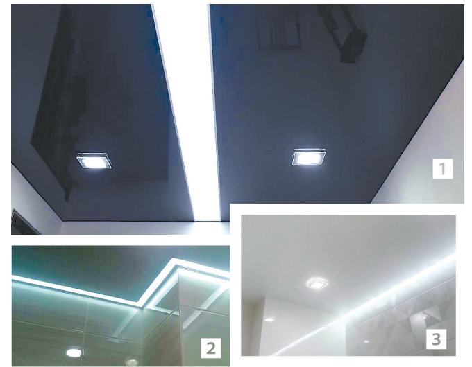
1 Натяжной потолок со световой линией 2 Потолок контурный 3 Парящий потолок
