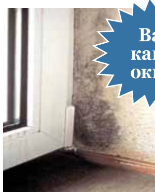
▲ Окно низкого качества после года эксплуатации
